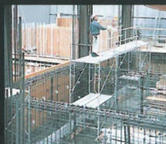
枠組足場で島を作る。
